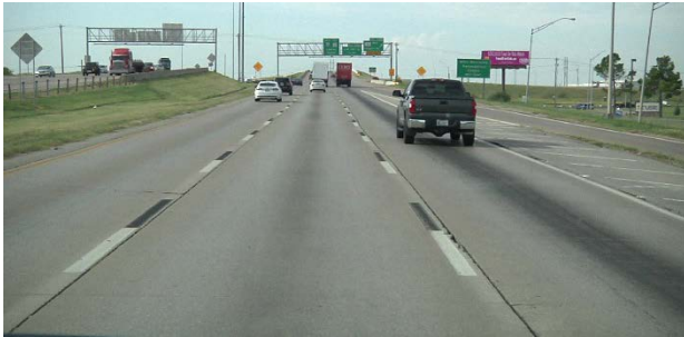
Rigid Pavement (OK-I44)
